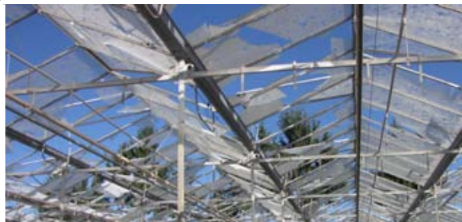
Le verre de cette serre fut totalement détruit et les cultures se trouvant dessous, anéanties
